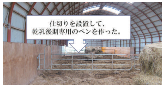
写真2 D型の中に仕切りを設置した。
