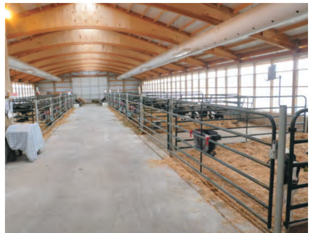
写真3 ダクト換気を取り入れた哺育育成舎 (米国)
