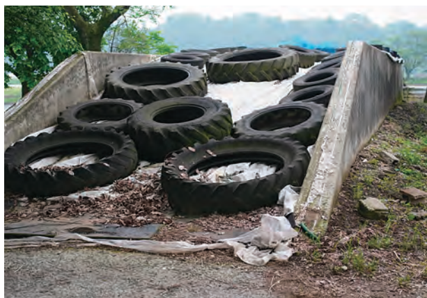
写真3 バンカーサイロ (3.8m幅×20m奥行×1.8m高さ)
