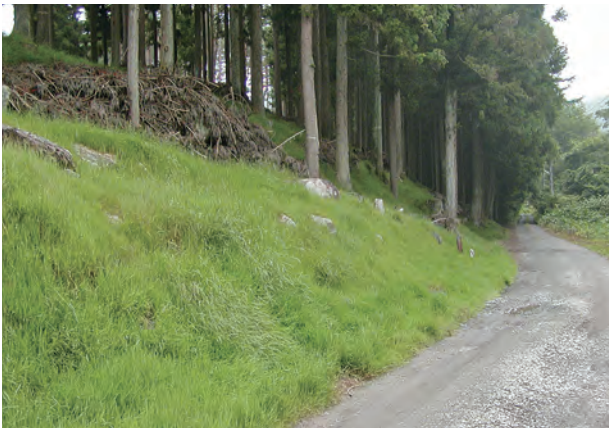
写真3 群馬県での施工例
