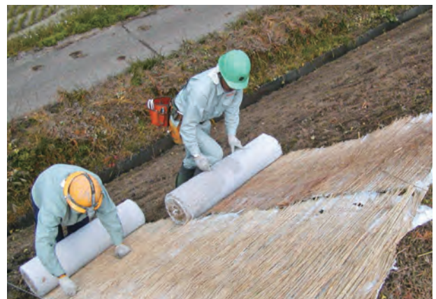
写真5 ワラ芝の敷設作業
