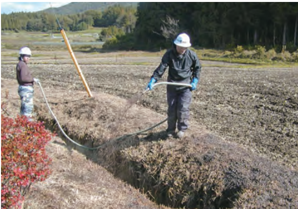
写真8 専門の緑化業者による吹付け作業
