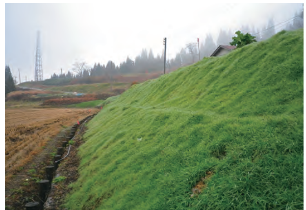
写真1 長野県での施工例
