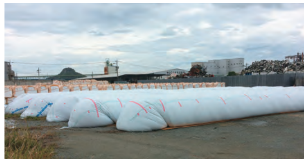
写真7 チューブバッグを活用した籾米SGSの保管状況
