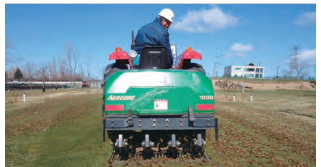
写真2 機械によるコアリング作業の一例
