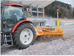
写真7 AIRFIBR専用機械による敷き均し
