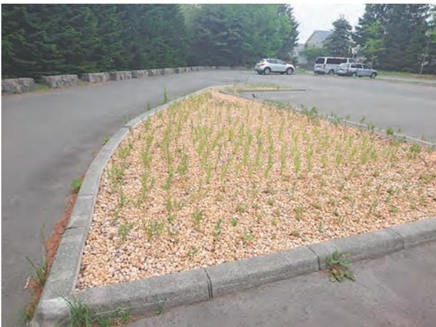
写真5 雨水浸透柵型花壇の造成1年後
