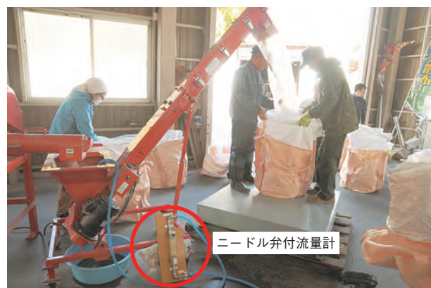
写真4 加水装置へのニードル弁付流量計の活用。バルブを調整することで、簡単に流量を変更することが可能。
