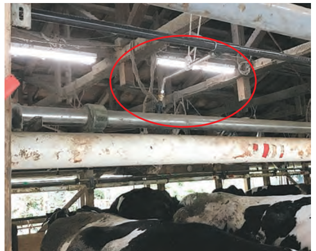
写真3 塩ビ管とノズル (A牧場)
