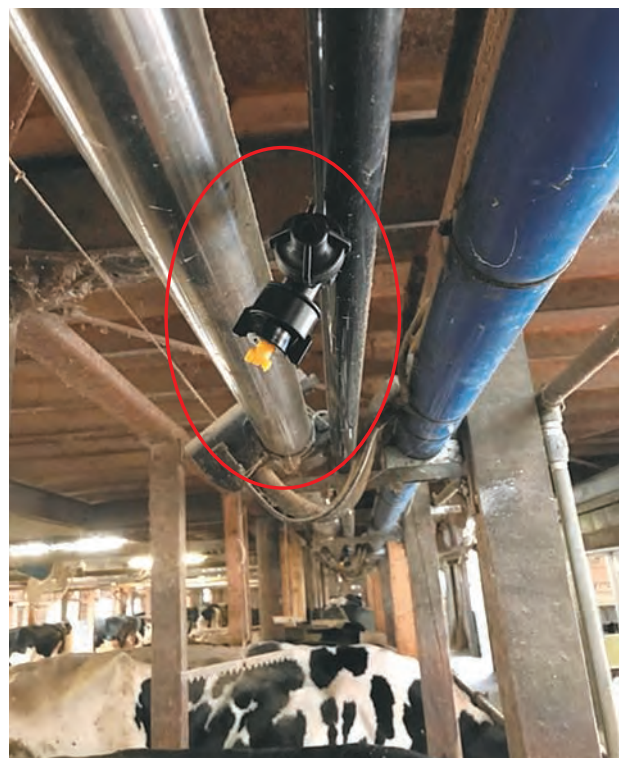
写真4 塩ビ管とノズル (B牧場)
