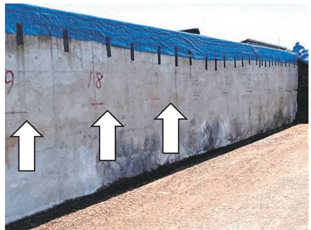
写真2 壁面に詰め込み厚の目安をペイント
