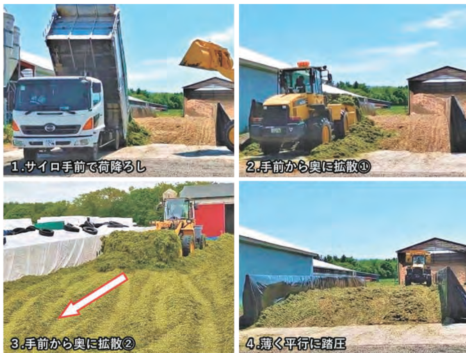
写真1 2層目の追詰め作業
