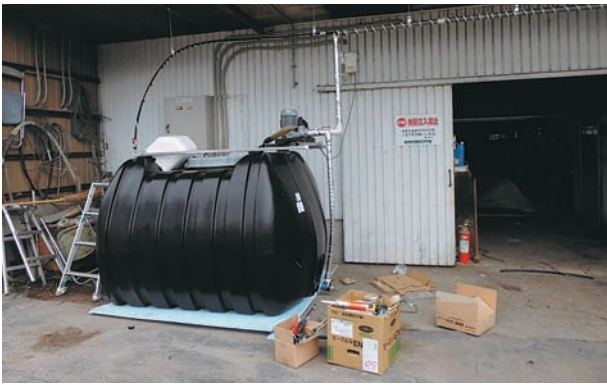
写真2 水量を確保するために設置した水タンク
