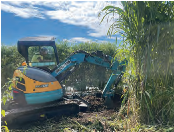
写真4 つちたろうの根の掘削調査
