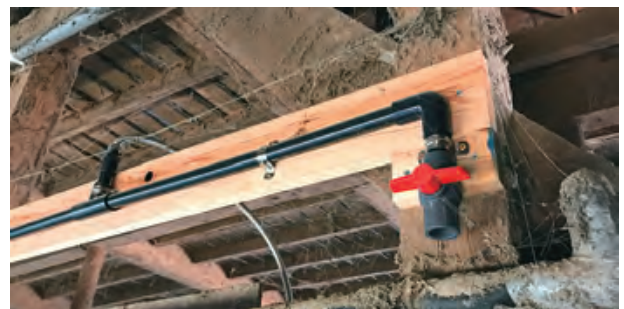
写真2 水抜き弁
