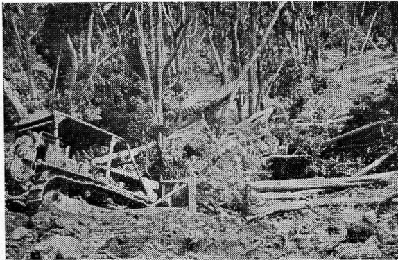
ハワイ島カホク牧野の開墾風景、ブルトーザで強引に倒木整理し、ここに牧草地を造る計画。
