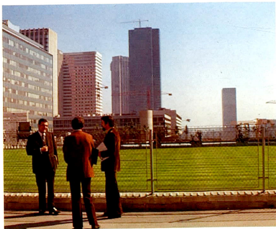
コンクリート上のニュータウンの建設 (フランス パリ)
