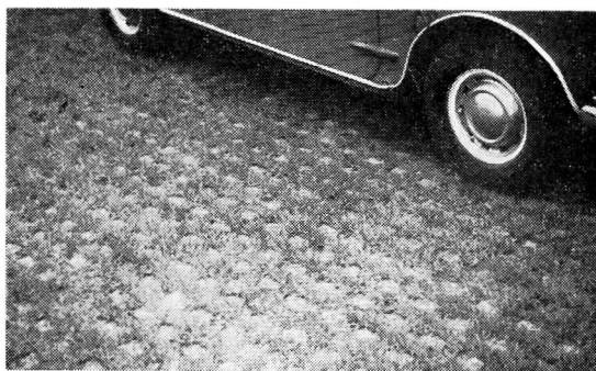
駐車場の緑化(コンクリート床上に造成した芝生) (イギリス パークシャー州)
