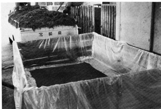
木枠を組み立てビニールを用意したところ
