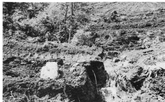
写真2 整地直後の降雨で崩壊の始まっている状況
