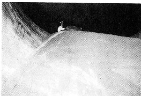
写真1 バッグ内にプロアで送風すると風船のようにひるがってサイロ内壁に密着する
