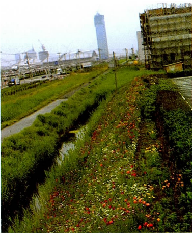
写真4 スノーミックスフラワーを利用したのり面緑花 (千葉県)
