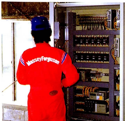
写真4 コントロールボックス。必要経費の40%を占める。群別の飼料構成・給与量・給与回数などをコントロールする
