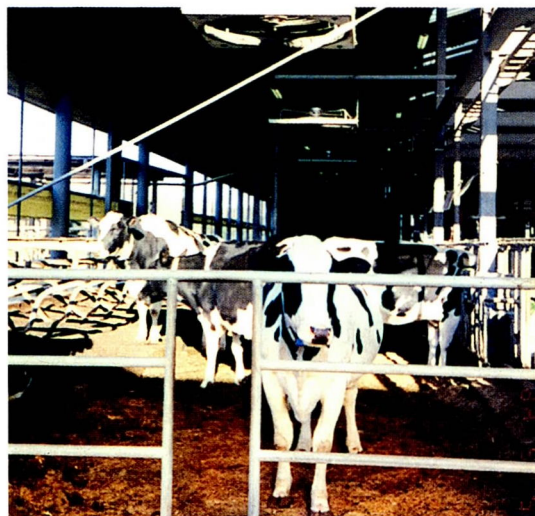
写真4 吹き下ろす形で換気扇を設置
