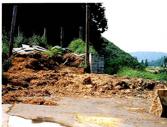
写真2 壊れた堆肥場（堆肥場が壊れたままでは…）
