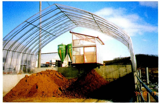
写真2 固液分離機の利用と一時貯蔵舎。簡易なビニールハウスでの貯蔵、1週間くらいで堆肥舎へ運搬
