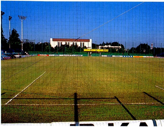
写真1 日立柏総合グラウンドの改修前の状況 (1993. 10. 11)
