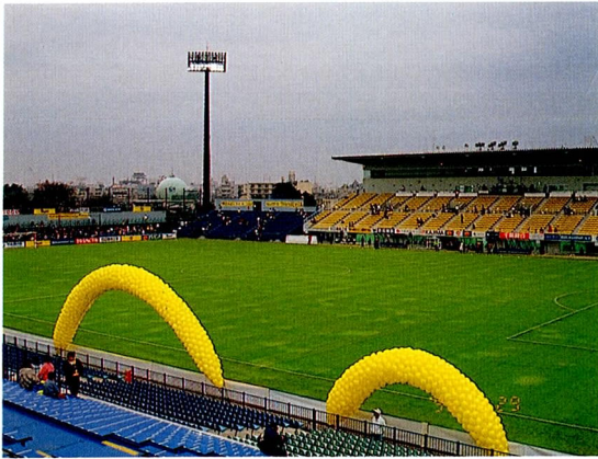
写真2 日立柏サッカー場の改修後の状況 (1995. 3. 29)
