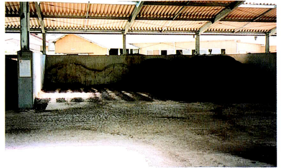
写真7 堆肥舎の通気ブロワ
