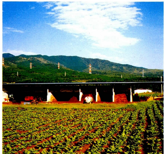
写真3 大村牧場の強制通気式堆肥舎
