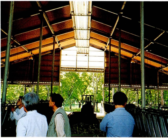
写真3 屋根のガルバリウム材
