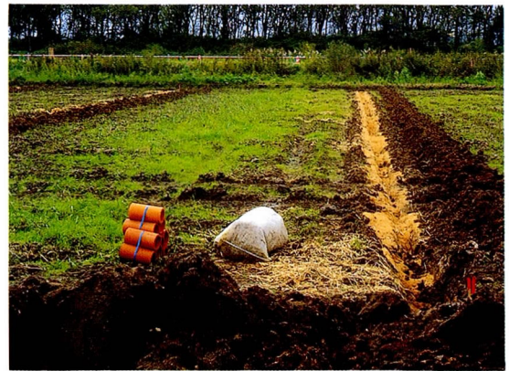
写真4 戸別での暗渠作業〈北海道長沼町〉
