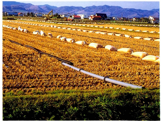
写真3 稲刈後、降雪迄の集落暗渠排水事業 〈北海道富良野市〉
