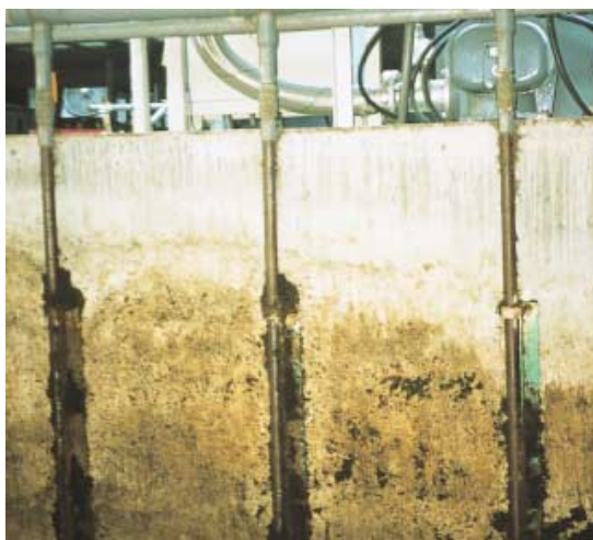
写真8 配管のアンクル材による固定と保護
