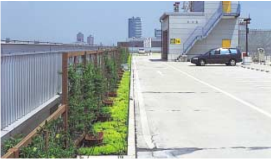
写真3 屋上の駐車場で利用されるスノーネオプラント
