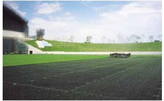
写真15 寒冷紗撤去状況
