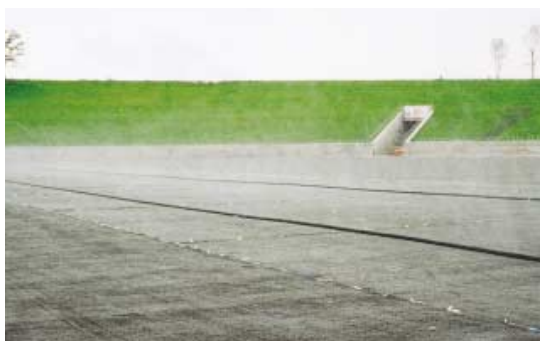
写真12 噴霧散水パイプ
