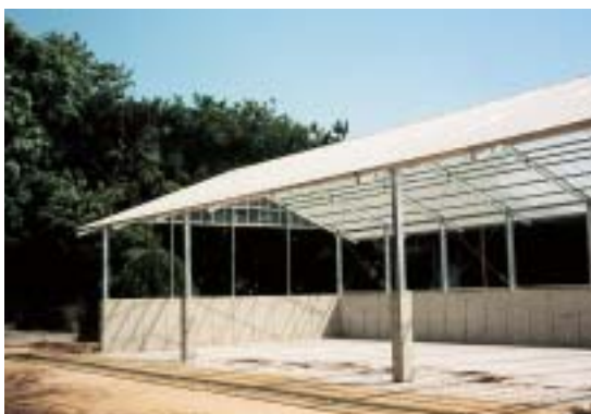
写真8 フッ素樹脂フィルムを屋根材に使った堆肥舎
