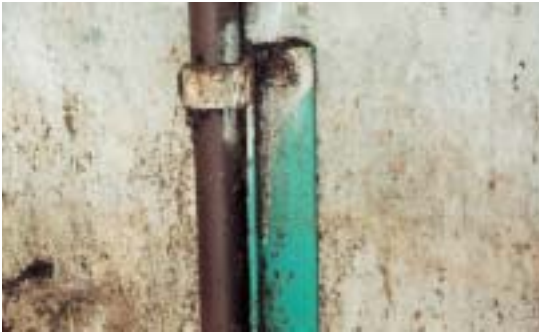
写真4 アングル材による配管保護
