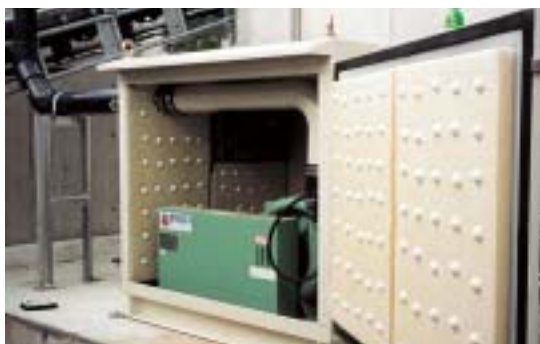
写真1 多段ブLOWERを防音ボックス仕様とした例
