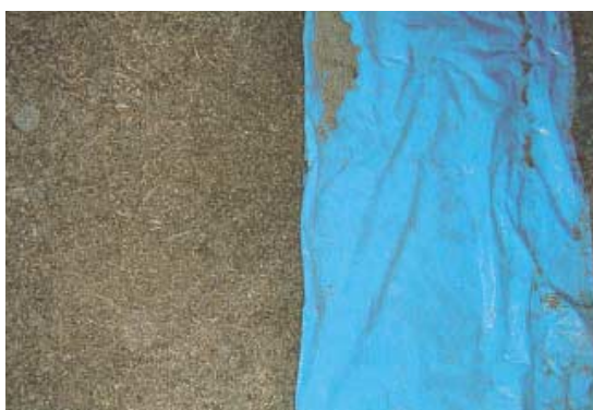
写真4 シート設置状態
