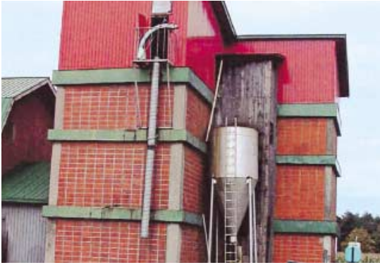
写真5 試験実施タワーサイロ
