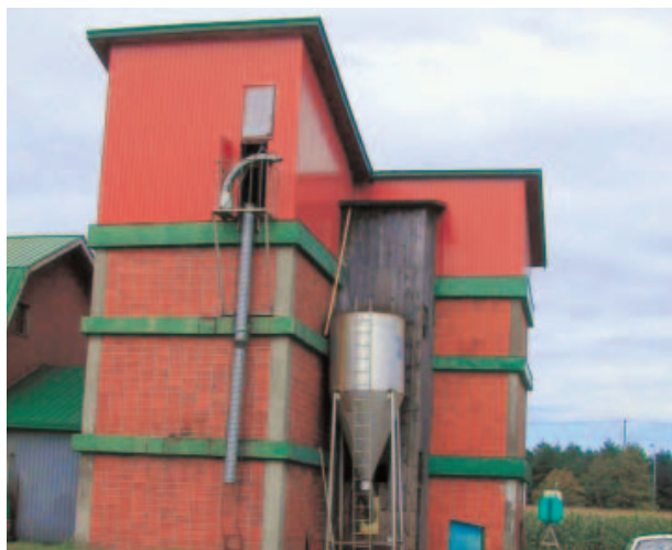
写真3 試験実施タワーサイロ
