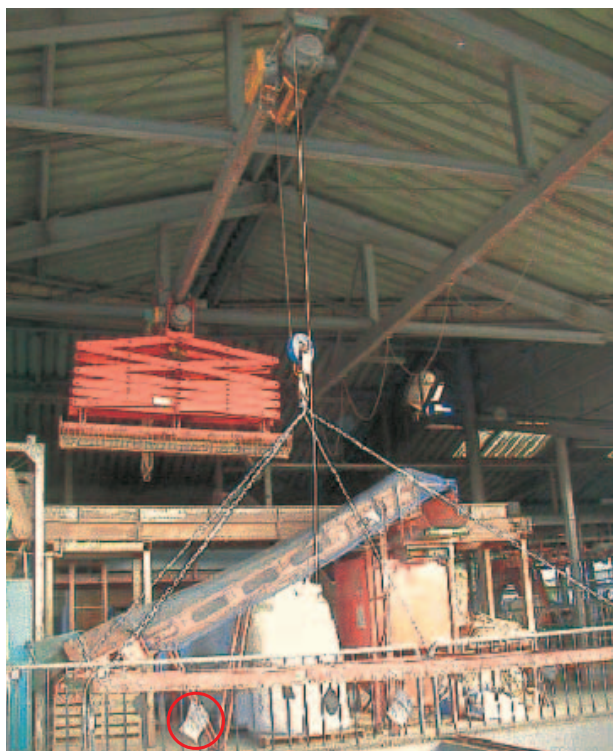
写真4 サイロ蓋の吊り下げ状態（見張番取り付け状態）
