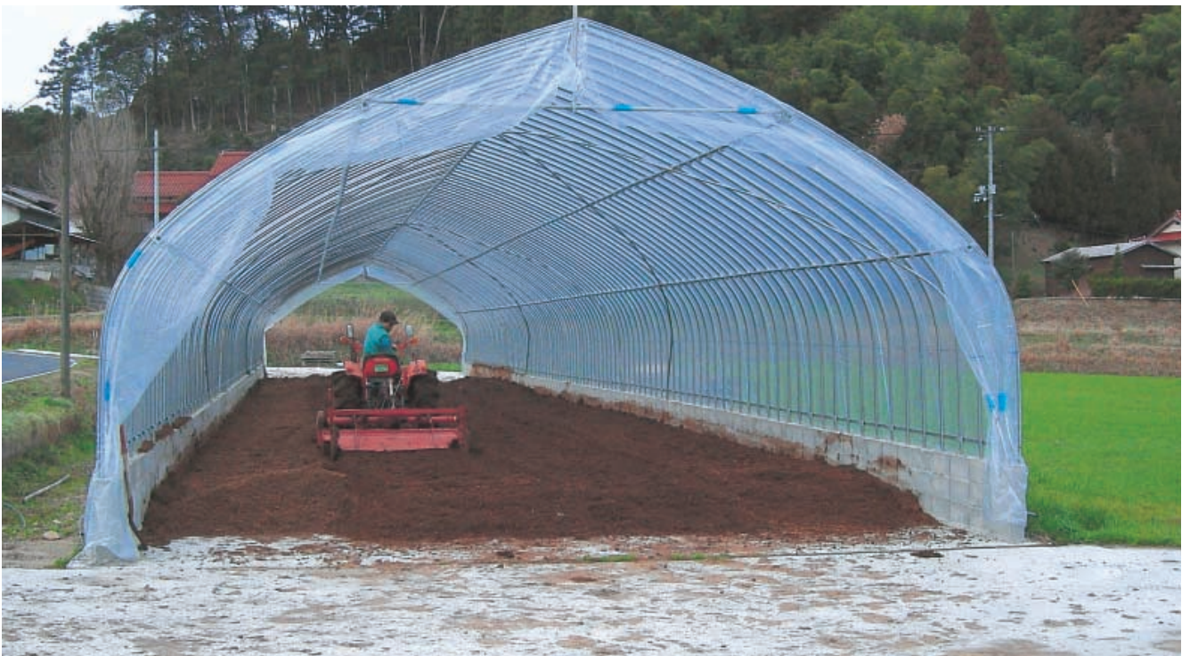
写真4 完成後の姿。棟にカラス避けの糸を張ることが必要。周囲の環境が一気に向上。悪臭が激減。自家労働で建築し、材料費は約115万円。処理終了後は低水分となるので、堆積して完熟、または戻し堆肥として利用。
