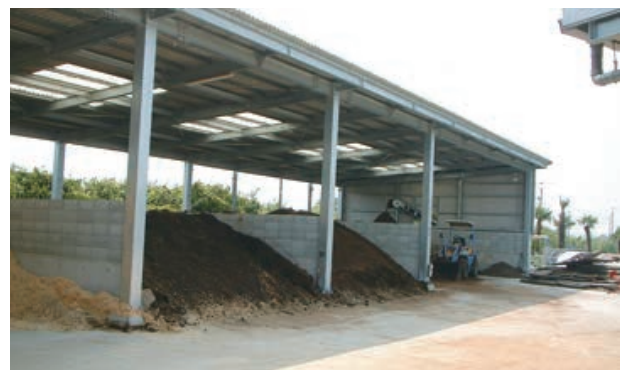
ハエのいない堆肥舎
