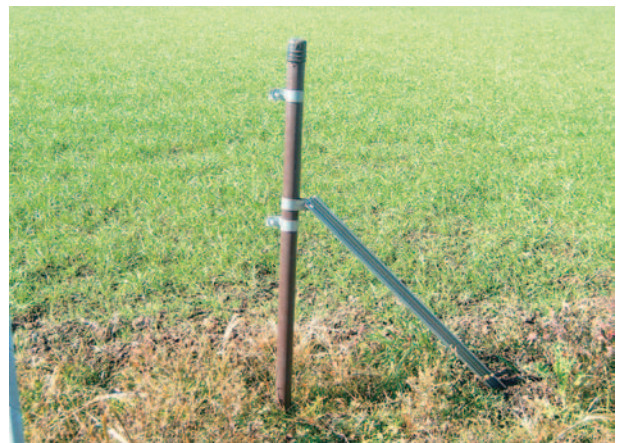
写真17 控え柱取付
