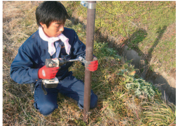
写真16 架線金具取り付け
