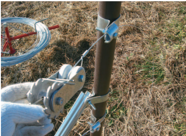
写真19 ストレーナー取付
