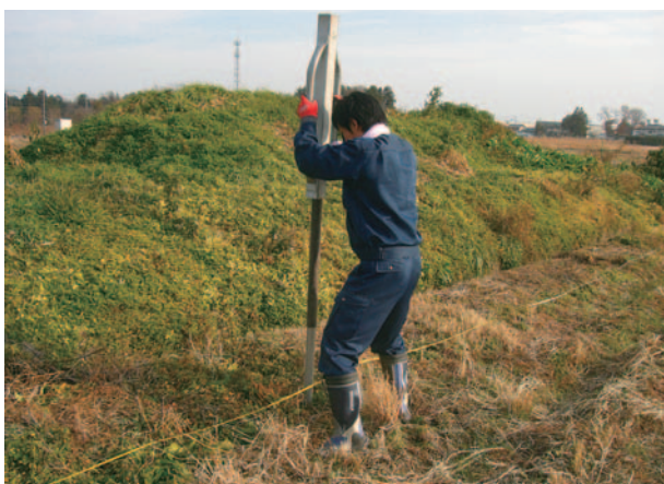
写真15 コーナー柱打ち込み
