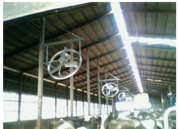
写真5 リレー式換気
