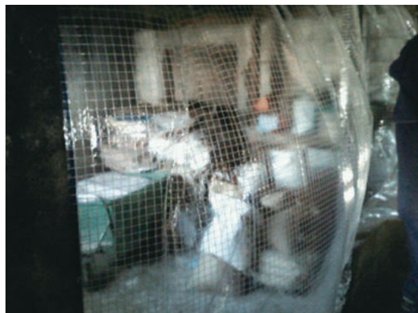
写真2 ビニールカーテンによる飼料庫から入気の閉鎖 トンネル換気の陰圧によりビニールが引っ張られている。
