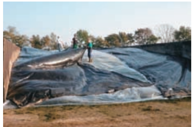
写真8 ビニールシートによるシート掛け
