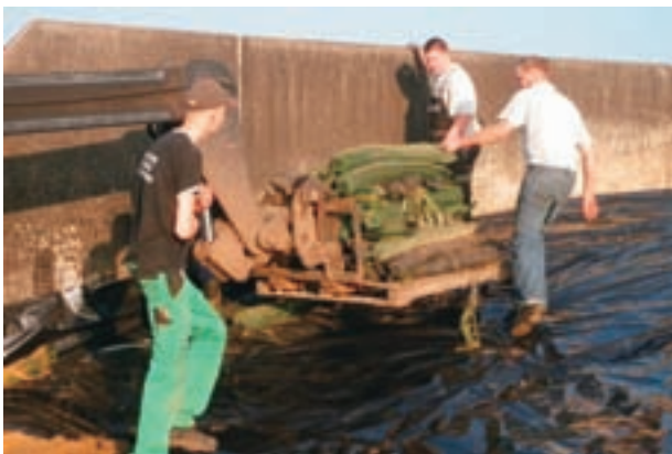
写真10 壁際にはグラベルバッグを隙間なく設置
