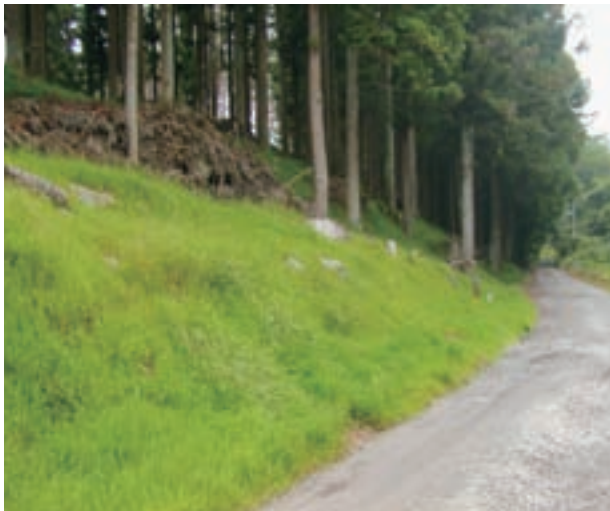
写真-4 畦畔グリーンによる法面の緑化 (群馬県、2012年7月3日撮影)
