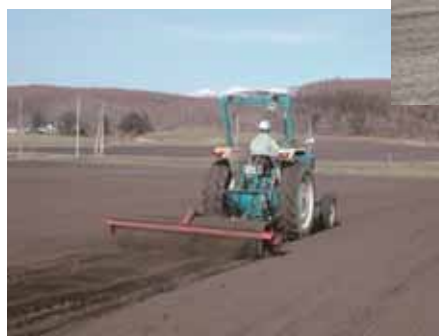
▲ローラーによる鎮圧
