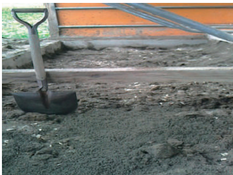
写真1. 砂ベッド改造時 深さ
