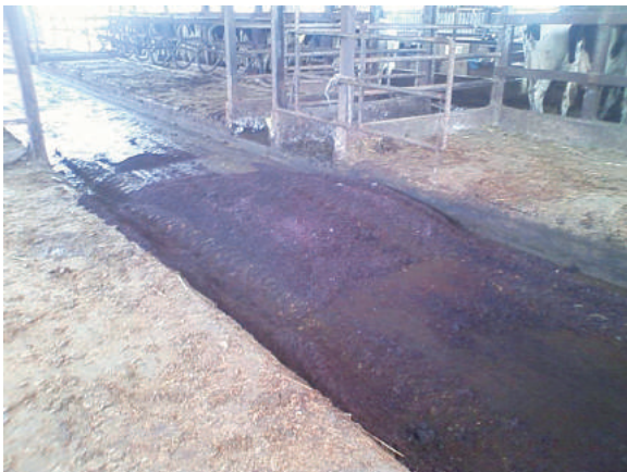
写真1. 改造途中のフリーストール乾乳舎
