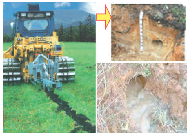
写真4 カuttingドレーン工法(横穴型) (北海道農業公社)
