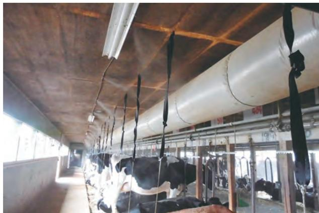
写真1. ダクトファン+ミストによる暑熱対策 (七飯Y牧場)
