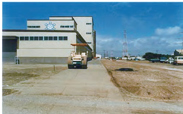
写真：建設中の苫小牧工場②
