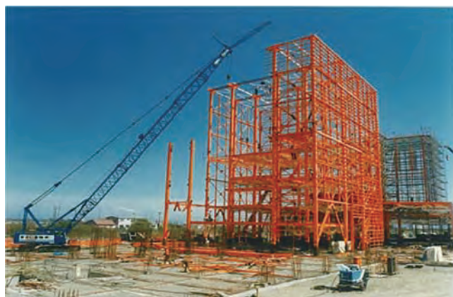
写真：建設中の苫小牧工場①
