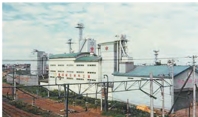
写真：木造から鉄筋へと近代化した新工場
