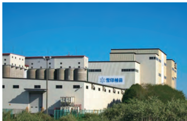
増築した製品倉庫(手前)
