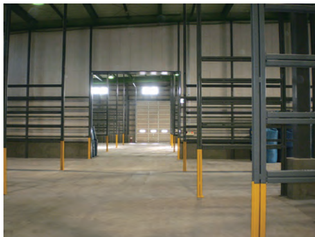
製品倉庫の内部
