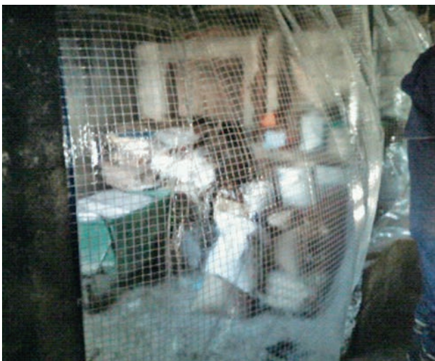
写真1 ビニールカーテンによる飼料庫から入気の閉鎖 トンネル換気の陰圧によりビニールが引っ張られている。
