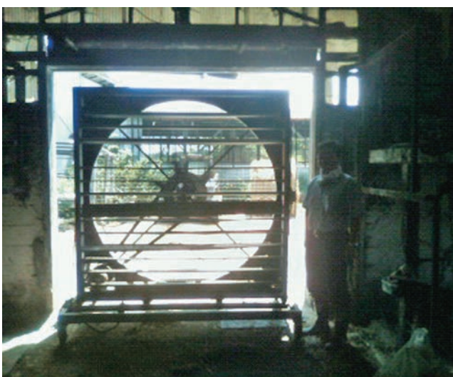
写真3 乾乳牛舎の大型ファン
